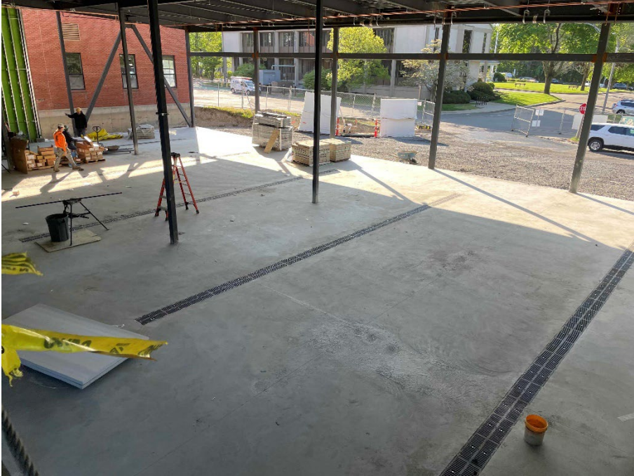
Apparatus Bay slab pour complete
